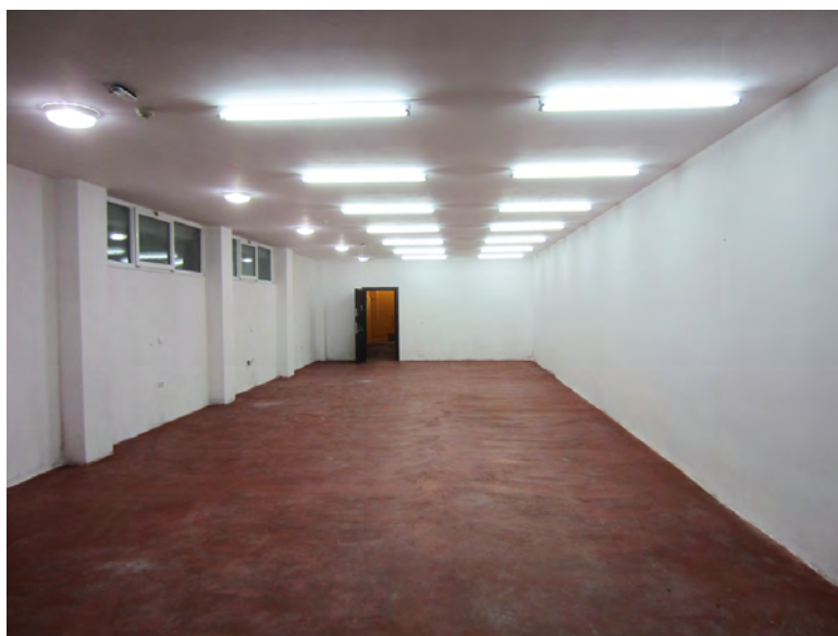
Fig. 4. Le sous-sol après les travaux.
