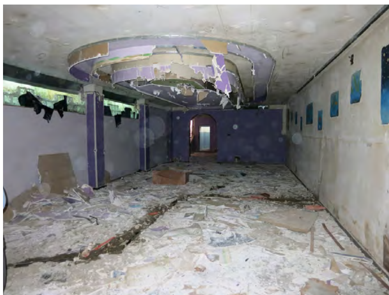
Fig. 3. Le sous-sol du nouveau bâtiment avant les travaux.
