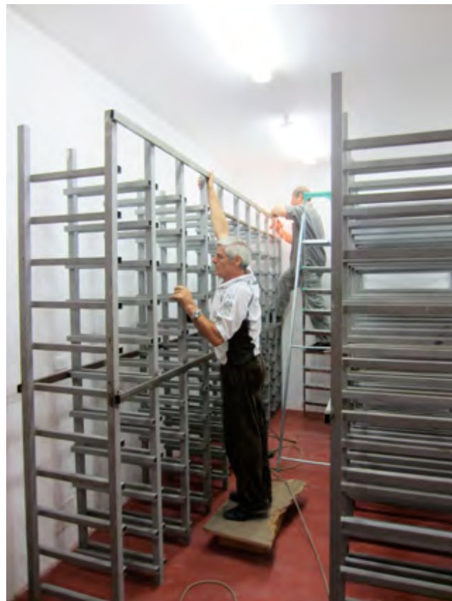
Fig. 8. Remontage des rayonnages métalliques dans la nouvelle réserve.
